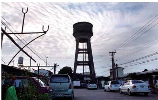
圖5-4 部分眷舍仍保有當初矮牆和竹籬笆牆。村內飲水多半由一座大型水塔供應，直至民國60年才裝設自來水。（屏北社大瘋光攝影社）
