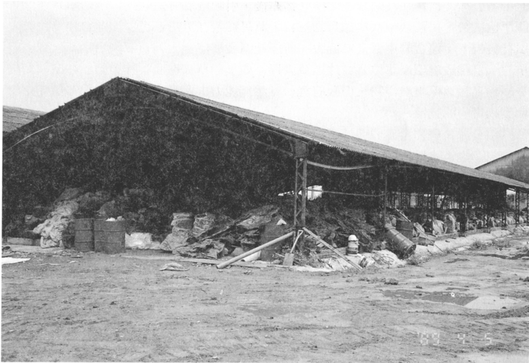
鯉魚山有毒化學廢棄物開挖堆置待處理的汞污泥
