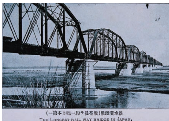
照3-11：下淡水溪鐵橋
