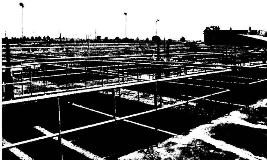
港西淨水場第一、二期工程 圖片來源：翁燕生攝
