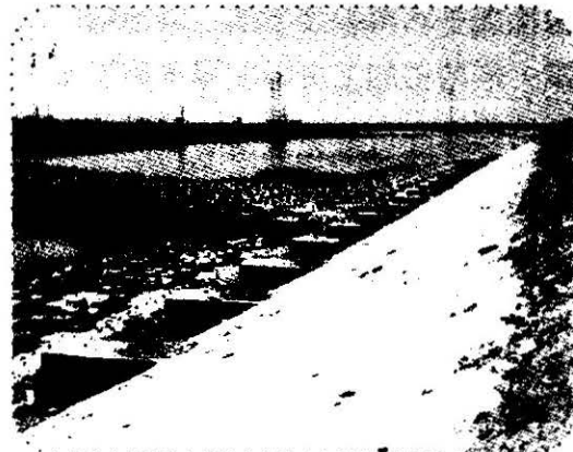
圖8 民國82年興建固床工右岸護坡工(攝影/沈明章)
