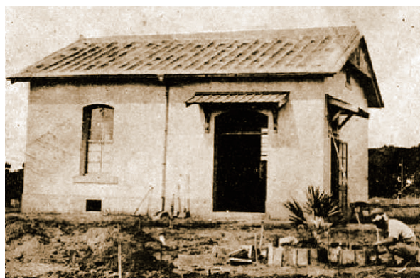
[圖9-13] 明治41年用咕啞石築城之殖育場事務室，其中一間為田代技師宿舍。
