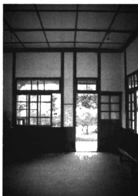
圖九 車站候車室牆面與天花板
