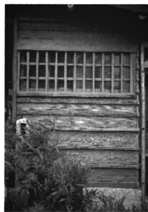
圖八 倉庫油燈庫外之木櫺窗戶與雨淋板
