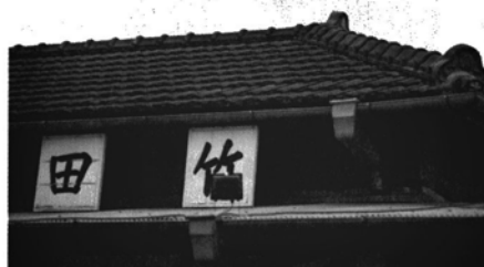
圖四 屋脊正脊棟瓦與隅脊
